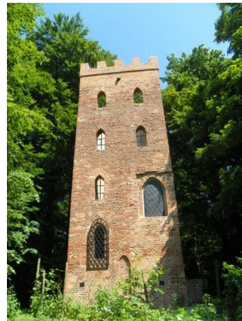
Rytířská bašta ve Wodzisławiu Śl. (před rekonstrukcí)
