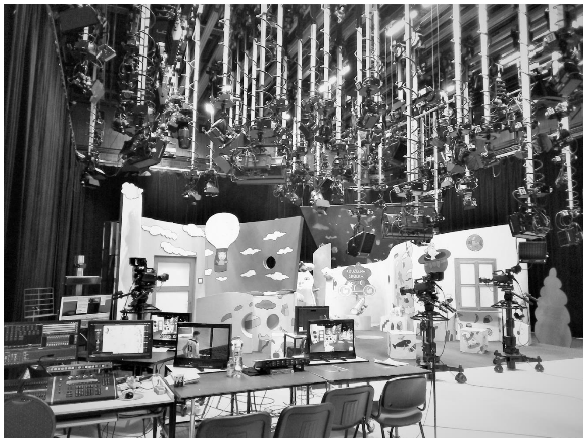
Obrázek 25 Plocha televizního studia s dobře patrným stropním roštem pro zavěšení osvětlovací techniky
